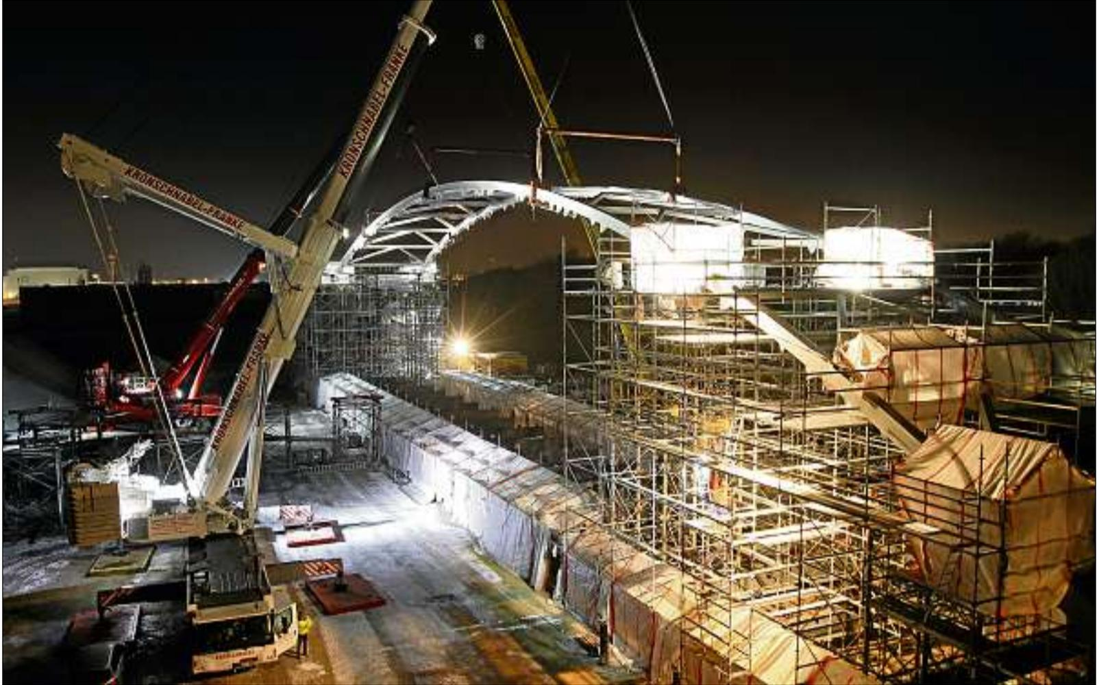
Selbst nachts wurde auf der Baustelle im Nordhäuser Schachtbauwerk an der Stahlbogenbrücke gearbeitet. Mittlerweile hat sie den Weg nach Wilhelmshaven angetreten, wo sie endmontiert wird, um die lange Reise nach Nordnorwegen in Angriff zu nehmen. Fotos: Schachtbau Nordhausen
