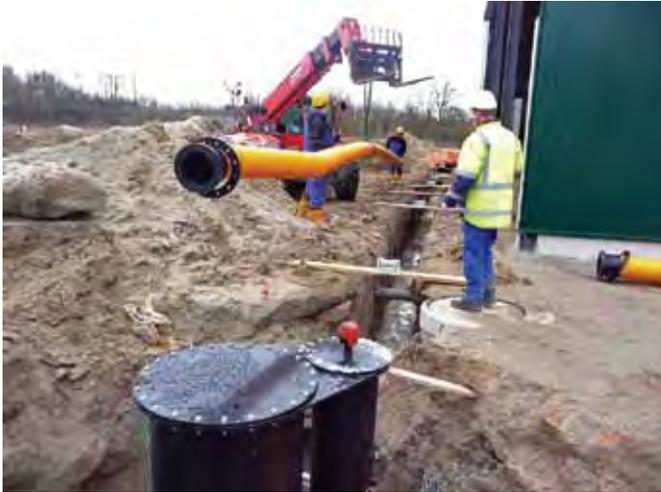
Schachtbauer verlegen eine Gasleitung zwischen zwei Kondensatschächten
