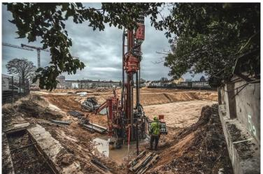
(2) Mittels Sonic-Drill Bohrgerät wurden hochwertige Bohrkerne zur Vorerkundung der Schadstoffverteilung entnommen.
