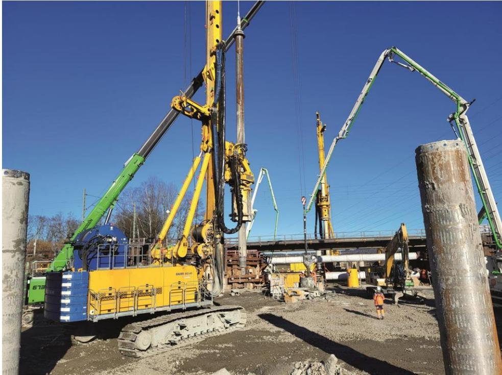
Eine BAUER BG 39 und eine BG 46 kommen bei den Bohrarbeiten zum Einsatz.
