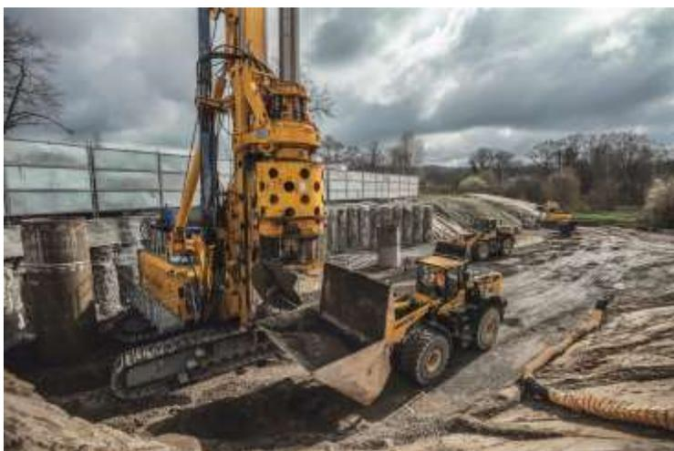
(2) Insgesamt werden rund 3.500 m<sup>3</sup> Erde ausgehoben und 6.000 m<sup>3</sup> schadstoffbelastetes Bodenmaterial in bis zu 15 m Tiefe mittels Großlochbohrungen ausgetauscht.
