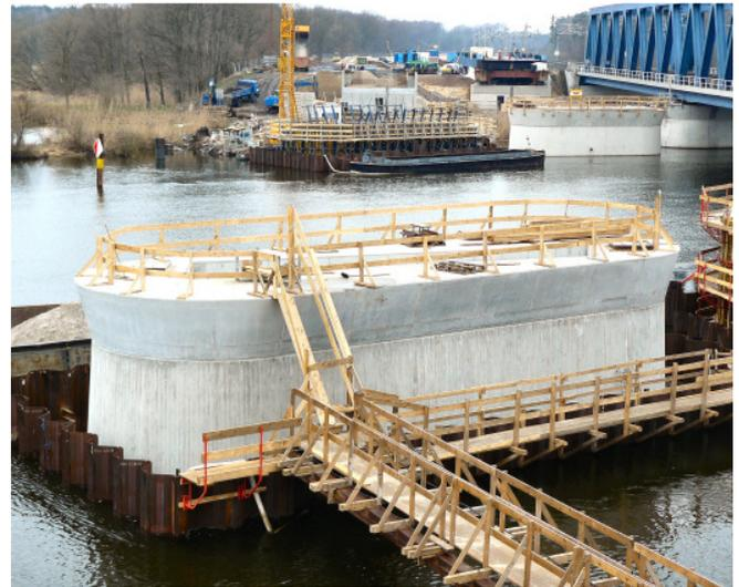
ca. 3.600 m<sup>3</sup> Beton zur Herstellung der beiden Strompfeiler
