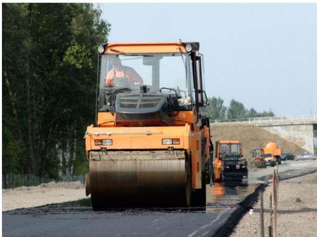
Einbau der Asphalttragschicht über insgesamt 2,2 km
