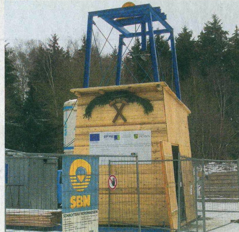
Allein diese Konstruktion der ausführenden Firma zeugt von den aufwändigen Arbeiten, die unter der Geyerischen Binge im Gang sind. FOTO: BERND MÄRZ
