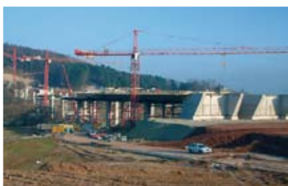
Мост Ринталь в г. Зольштет (автомагистраль А38)
