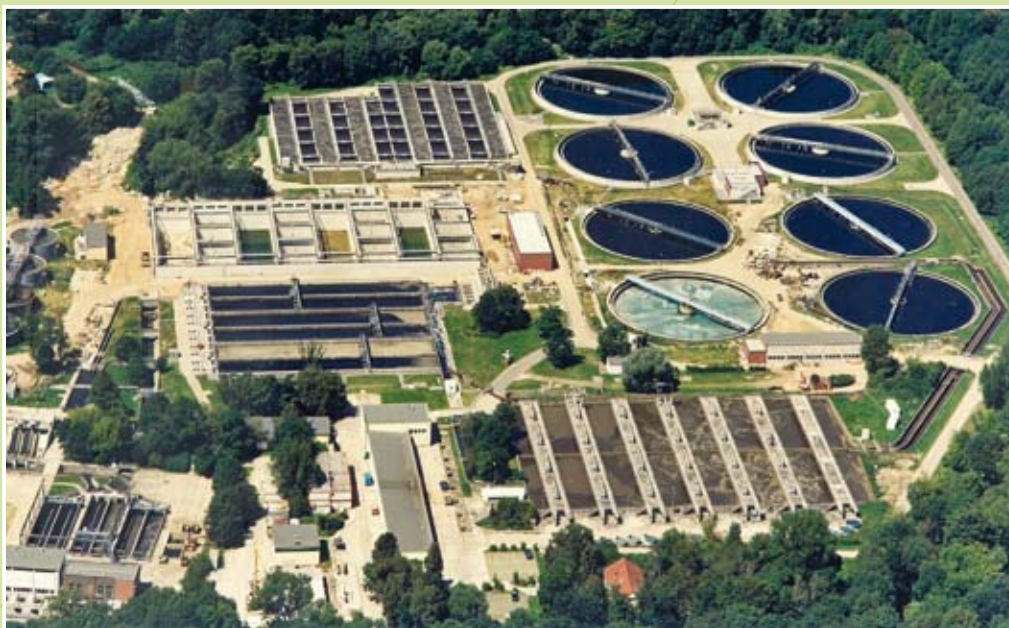
Очистная установка сточных вод в г. Лейпциг/Розенталь
