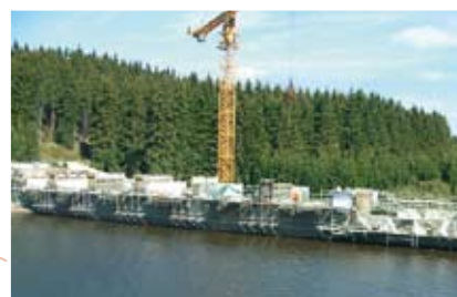
Мост через сброс паводковых вод Кёнигсхютте
