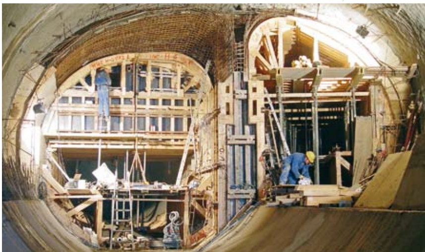
Возведение опалубки в штольне Мюглицталь
