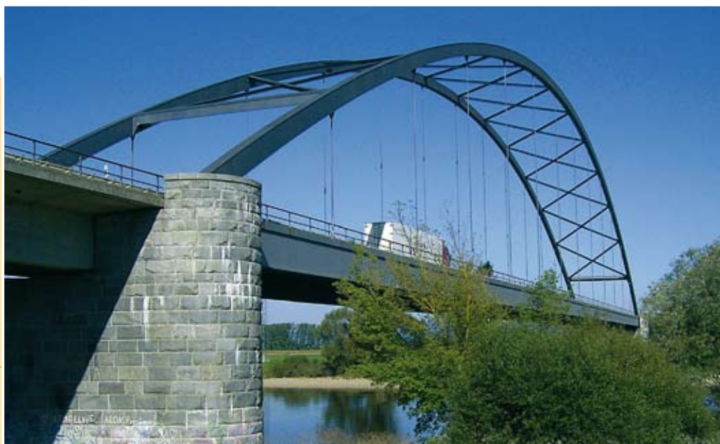
Мост через Дунай, г. Штраубинг (трасса B20)
