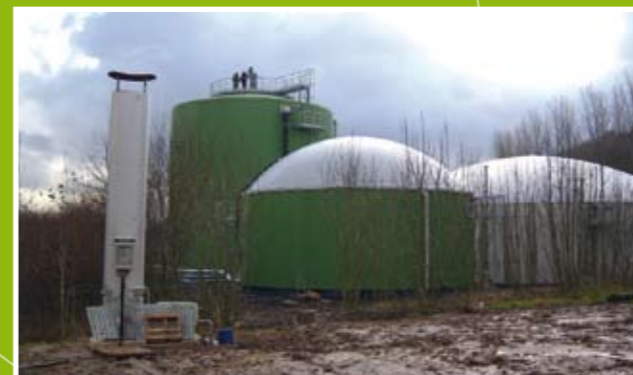
Biogasanlage Iggenhausen (NRW)
