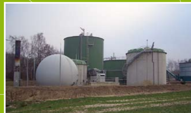
Biogasanlage Georgsmarienhütte (NDS)
